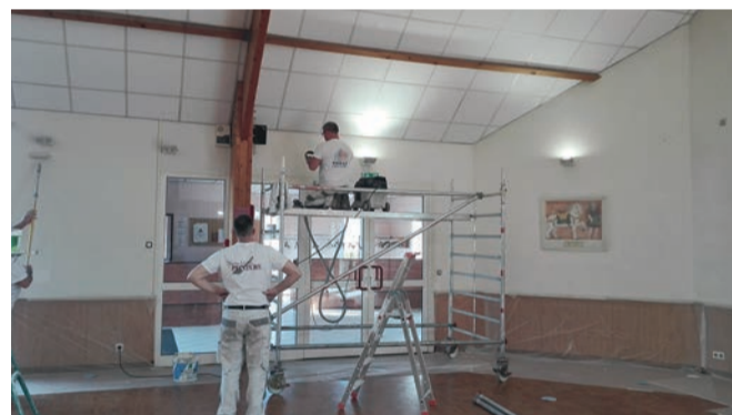
Travaux salle Denise Egasse : électricité, éclairage, faux-plafond, peinture, écran projection
